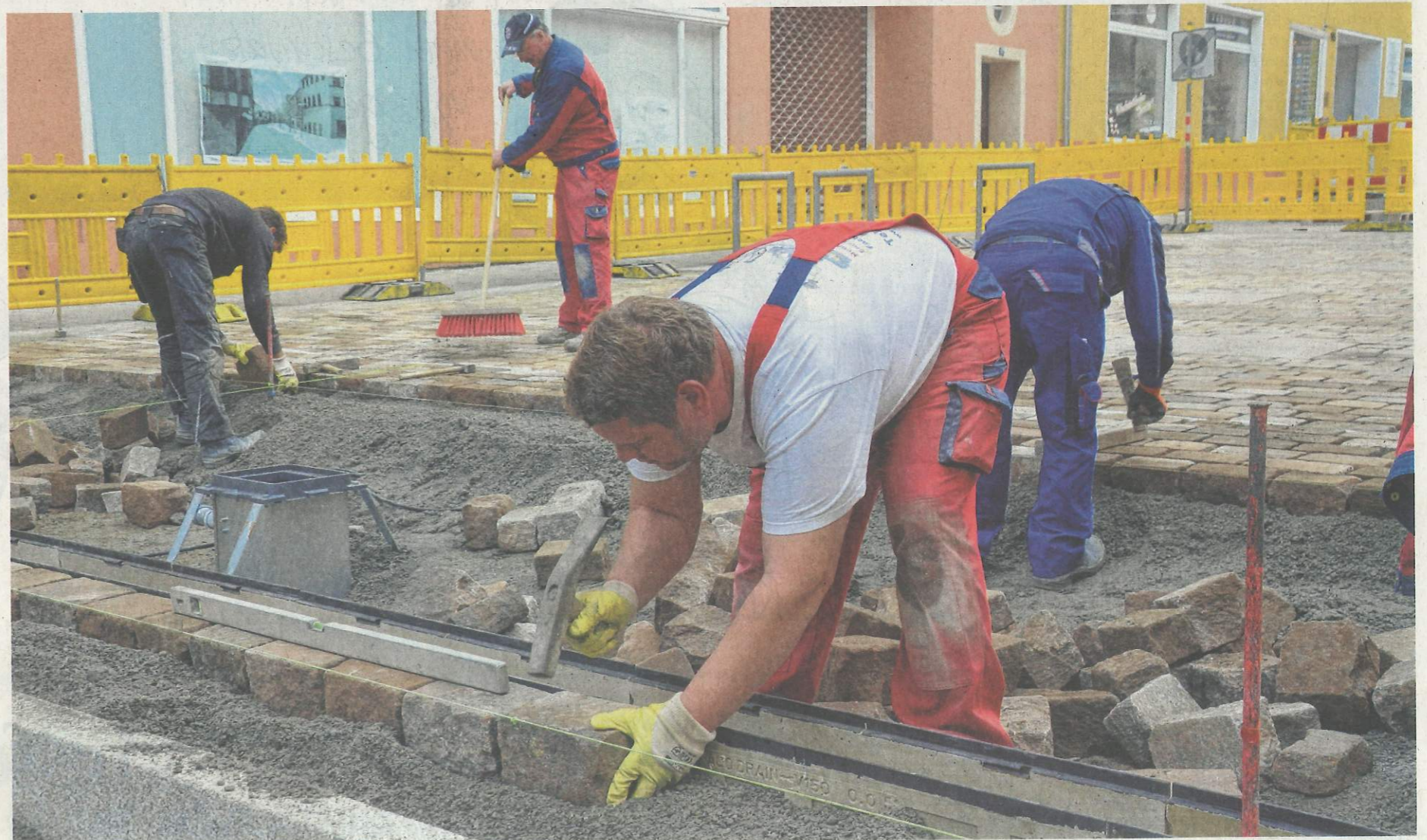
Fast vollendet sind die Pflasterarbeiten zur Neugestaltung der Bäckerstraße. Nur noch wenige Meter haben die Mitarbeiter der Bauunternehmung EZEL vor sich. Foto: TZ/ K. Engel
